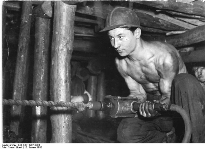
Abbildung 2: Bergarbeiter Sprenglöcher bohrend / Quelle: Bundesarchiv, Bild 183-13287-0006 / CC-BY-SA 3.0
